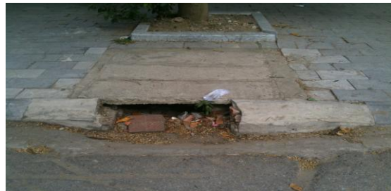
Hình 2. Thu nước mặt đường trực tiếp qua bó vỉa gây mất mỹ quan đô thị
