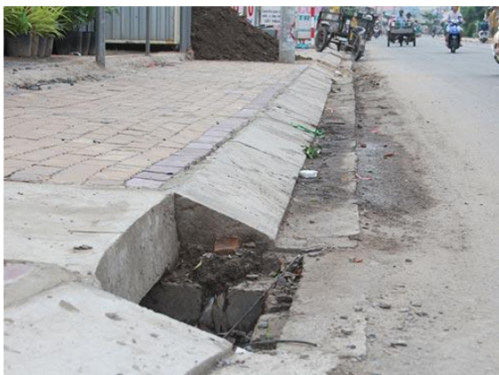
Hình 5. Ga thu kiểu hàm ếch kết hợp với lưới gà giúp ngăn mùi
