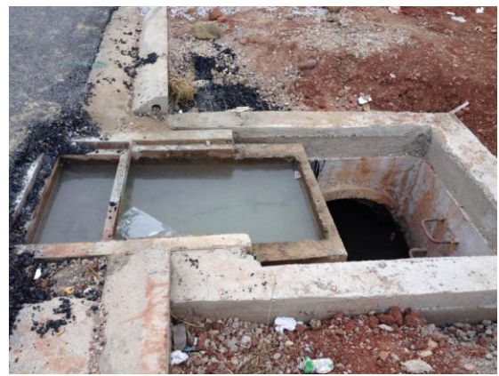
Hình 5. Ga thu kiểu hàm ếch kết hợp với lưới gà giúp ngăn mùi
