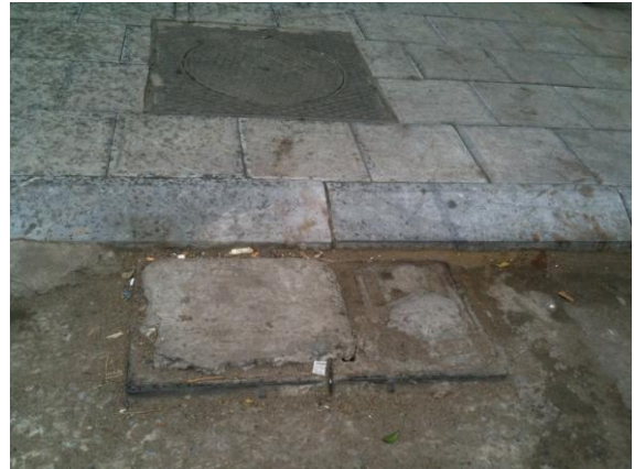
Hình 4. Thu nước từ mặt đường đầu tư mới bị dân che lấp do không đảm bảo ngăn mùi hôi
